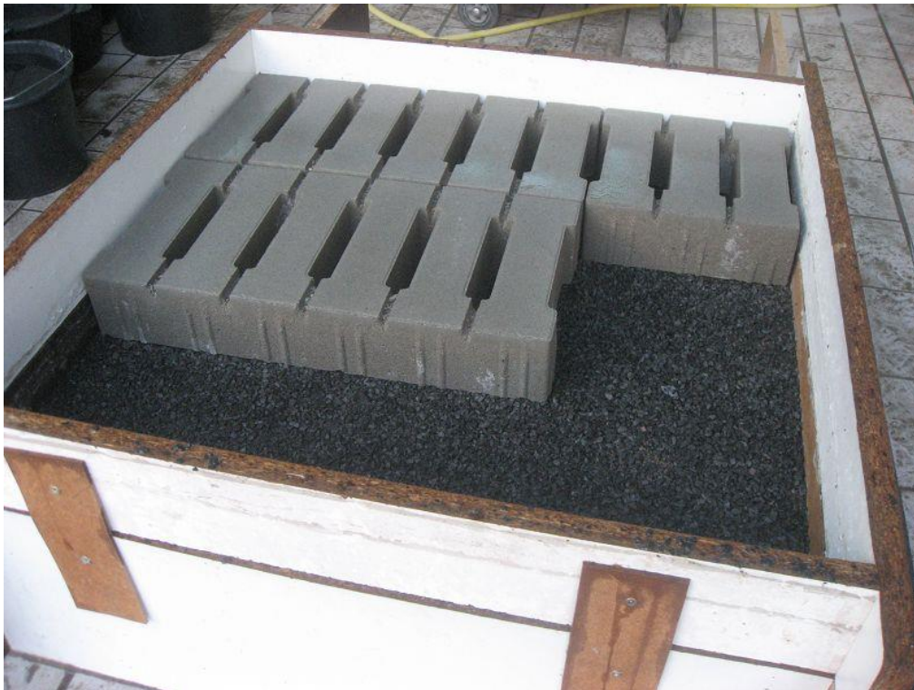
Abbildung 1: Verlegung im Hartsteinsplitt 2/5 mm
